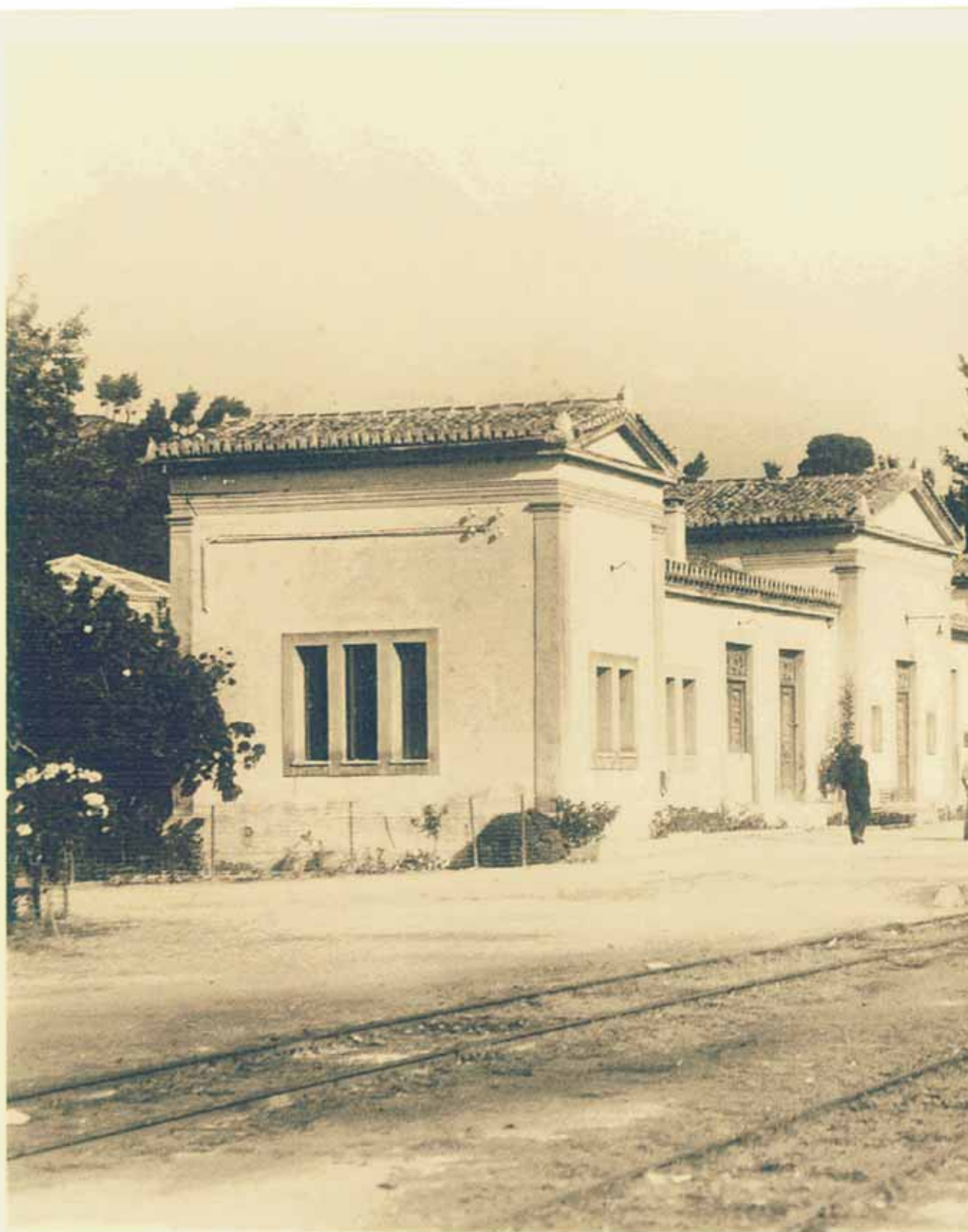
ΟΛΥΜΠΙΑ. Ο σιδηροδρόμος
